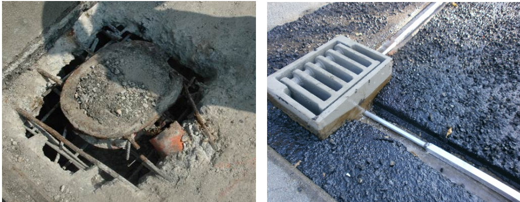
15. ábra: Kibontott víznyelő a pályaszinten, beépített új víznyelő és burkolatszivárgó
