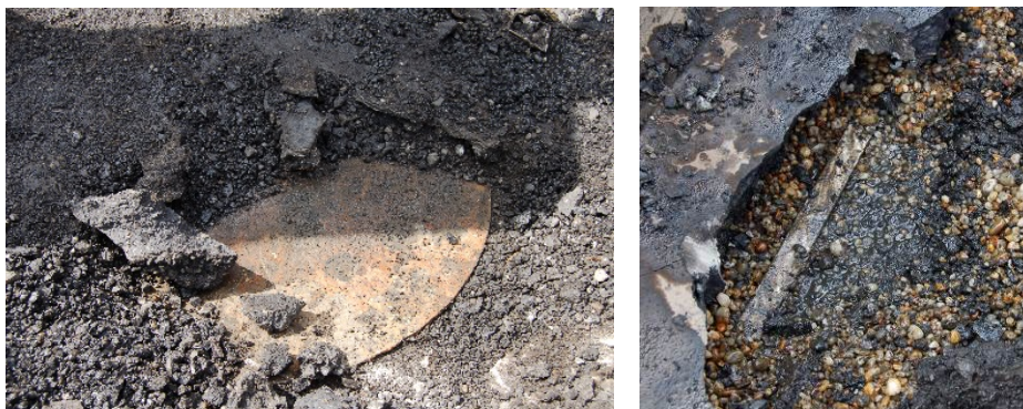
13. ábra: Vaslappal lefedett víznyelő, nedves kavicsagyazat a burkolatszivárgó mellett
