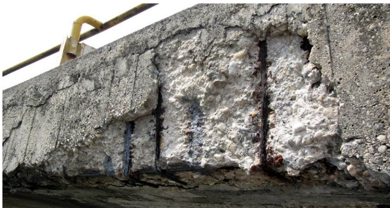
14. ábra – A szegélyek betonfedésének leválása
