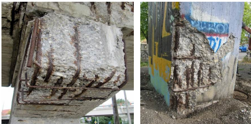
11. ábra: A pillérkonzolok károsodása, a betonfedés táblás leválása a pilléreken
