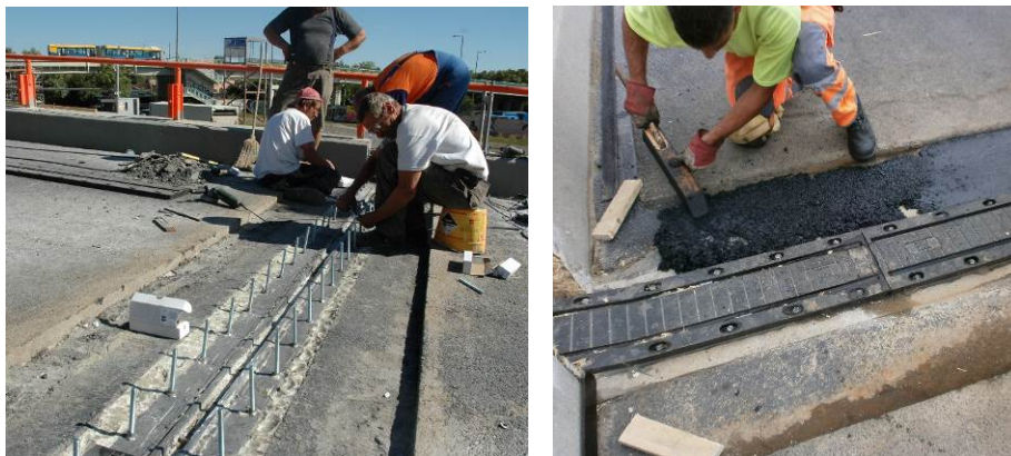
16. ábra – A meglévő dilatáció szerkezet előkészítése
